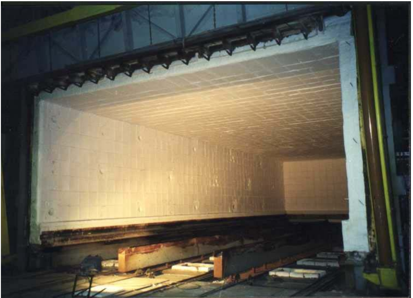
Figure N°17 : présentation du revêtement d'un four par des FCR (ECFIA, 2005)
